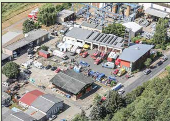
Einsatzleitung und Versorgungszug am Gerätehaus Bad Schandau
