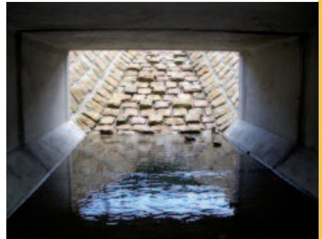
Durchlass am Elbdamm vor der Prallwand
